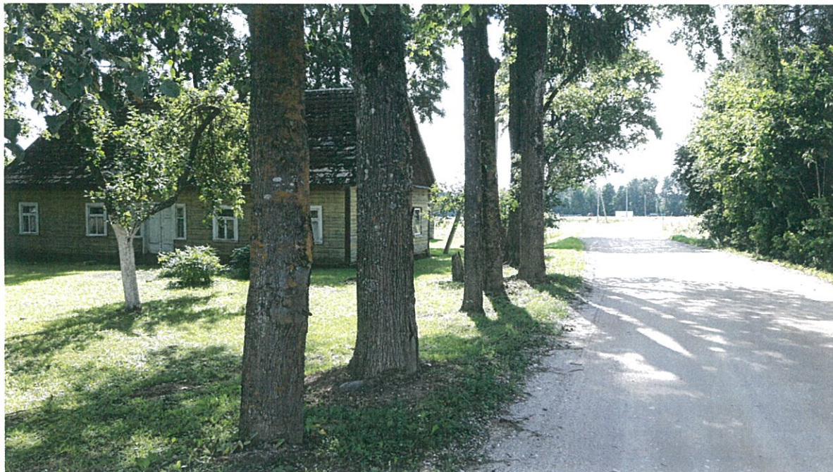
2 Pav. Nagrinėjamo kelio ruožo techninė būklė
